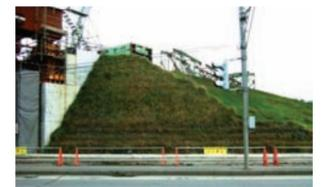
▲補強材を敷設して建設中の高速道路
